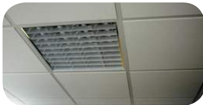
Doublage par mise en place de faux plafond sans amiante.
