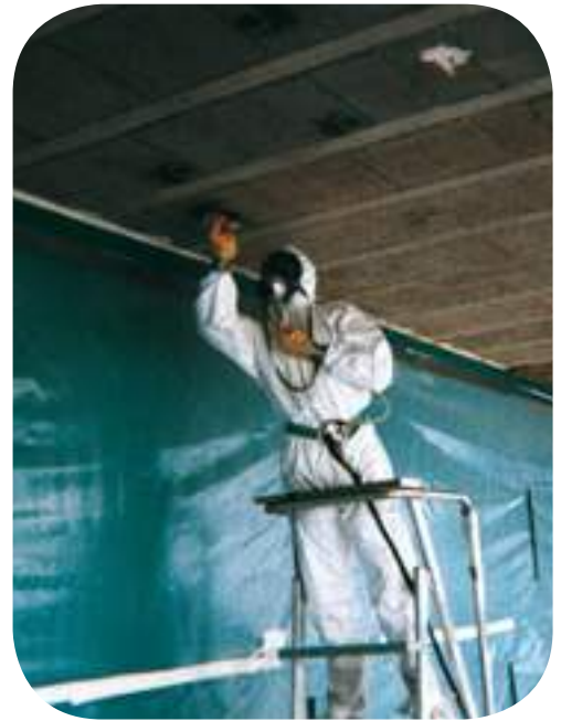
Travail de finition sur une nacelle mobile.
