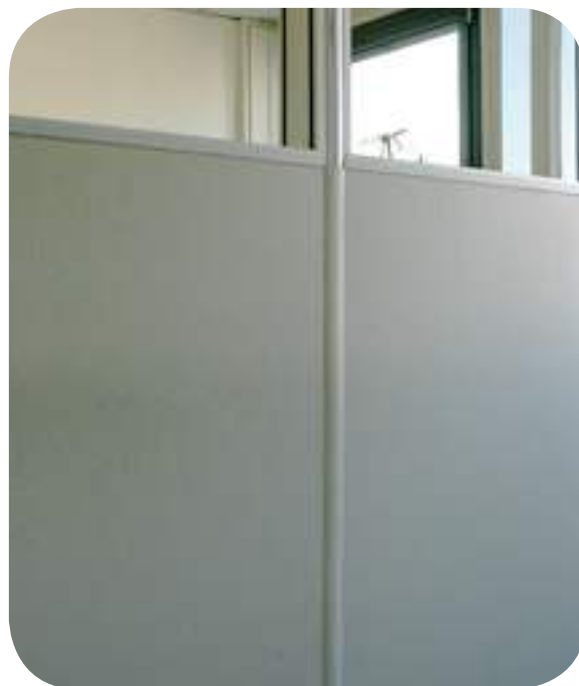
Cloison en amiante-ciment.
