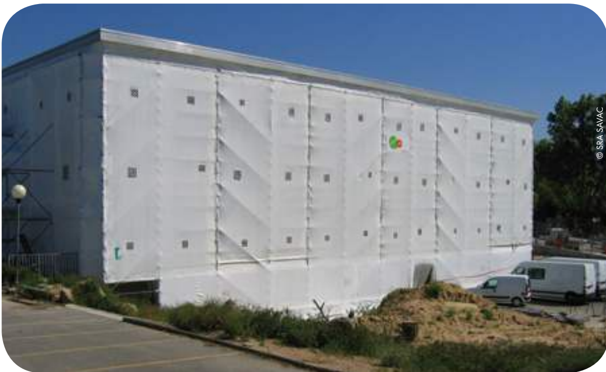
Confinement total d'un bâtiment.
