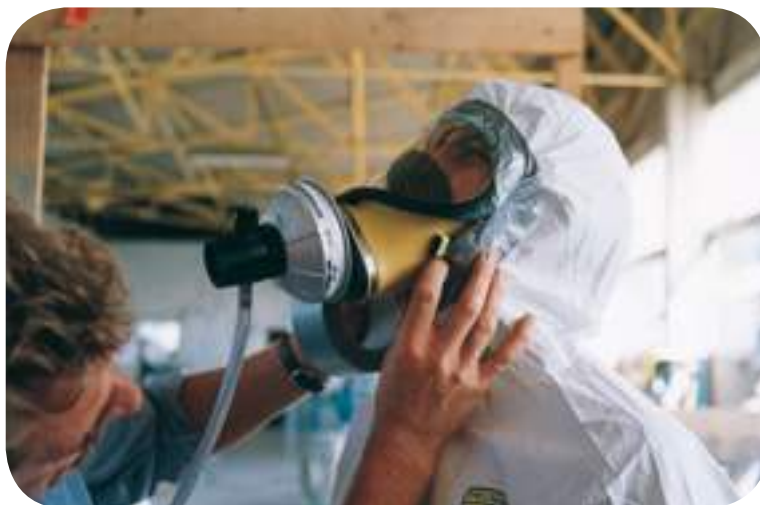
Avant l'entrée en zone, chaque opérateur fait vérifier l'étanchéité et le bon fonctionnement de son équipement par un autre opérateur (photo AFPA)
