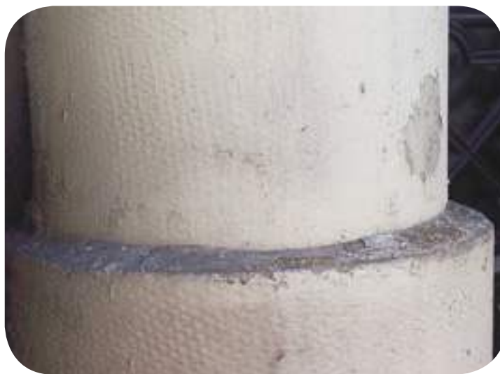
Conduite en amiante-ciment à l'intérieur d'un local
