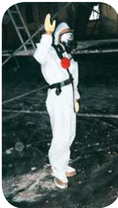
Masque complet à ventilation assistée et filtre TM3 P fixé sur le masque.
