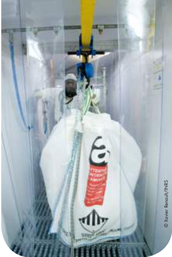
Tunnel déchets équipé de moyens de manutention.
