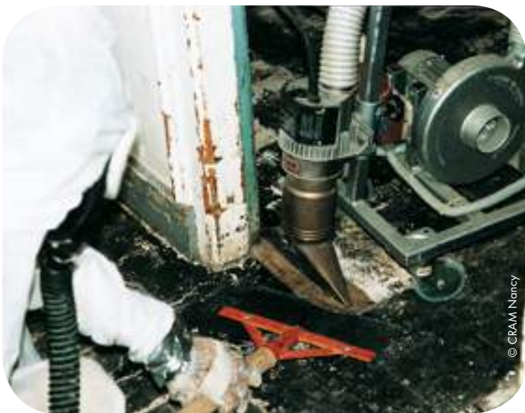
Décollement des dalles à la spatule.
