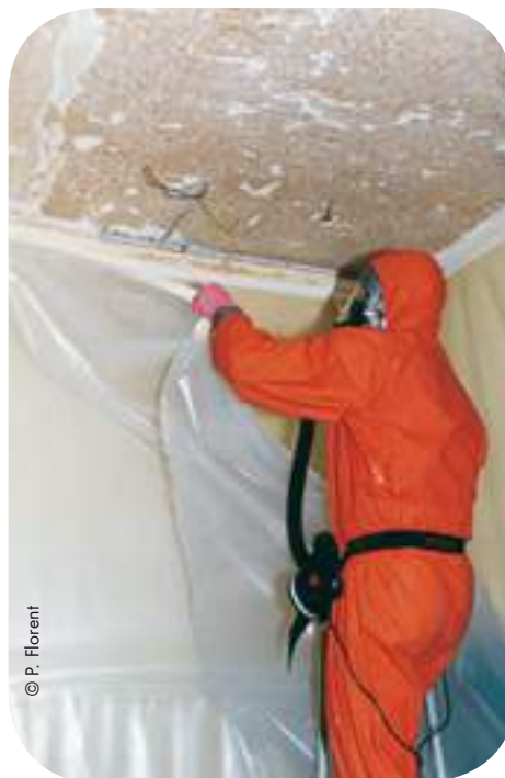
Dépose de la première couche de films en matière plastique.
