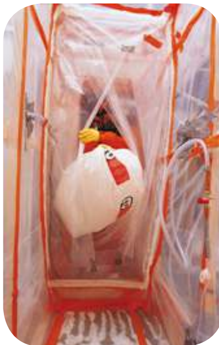
Sortie de déchets d'amiante après douchage du sac.
