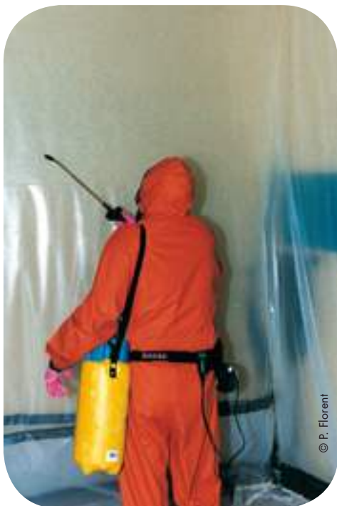
Application d'un surfactant sur les films.
