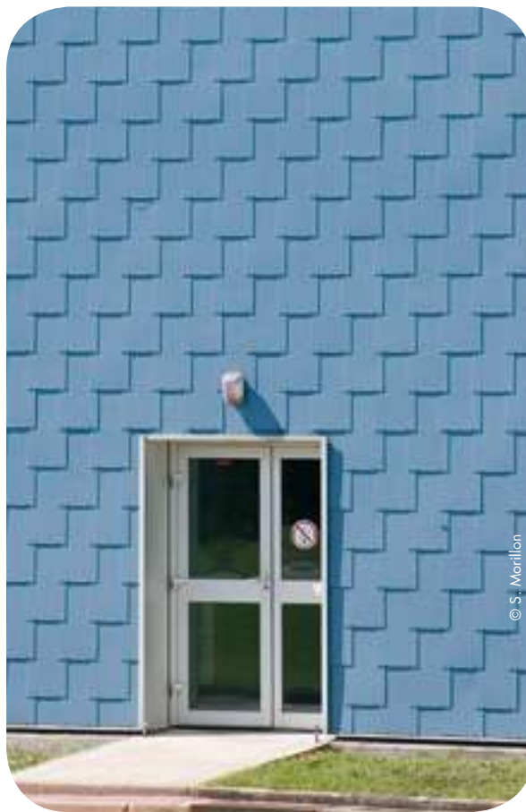
Bardage en amiante-ciment.
