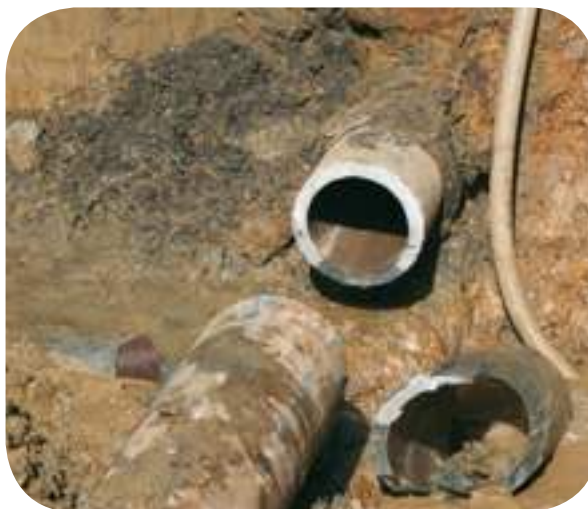
Canalisations en amiante-ciment.
