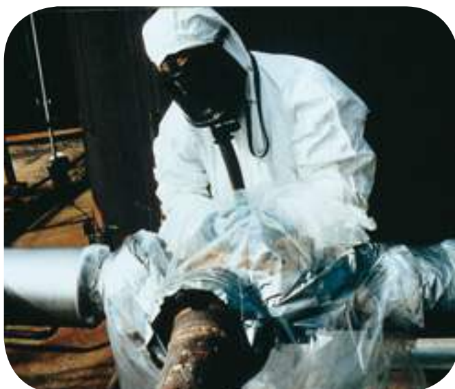
Intervention en extérieur sur une bride à trois voies, à l'aide d'un sac à gants.
