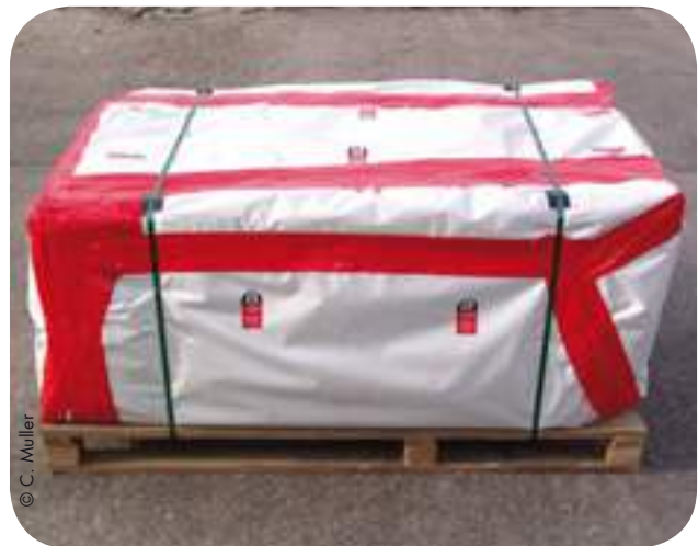
Emballage de plaques d'amiante-ciment sur palette
