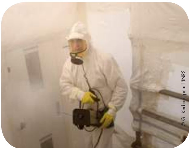
Test de fumée à l'intérieur du confinement.
