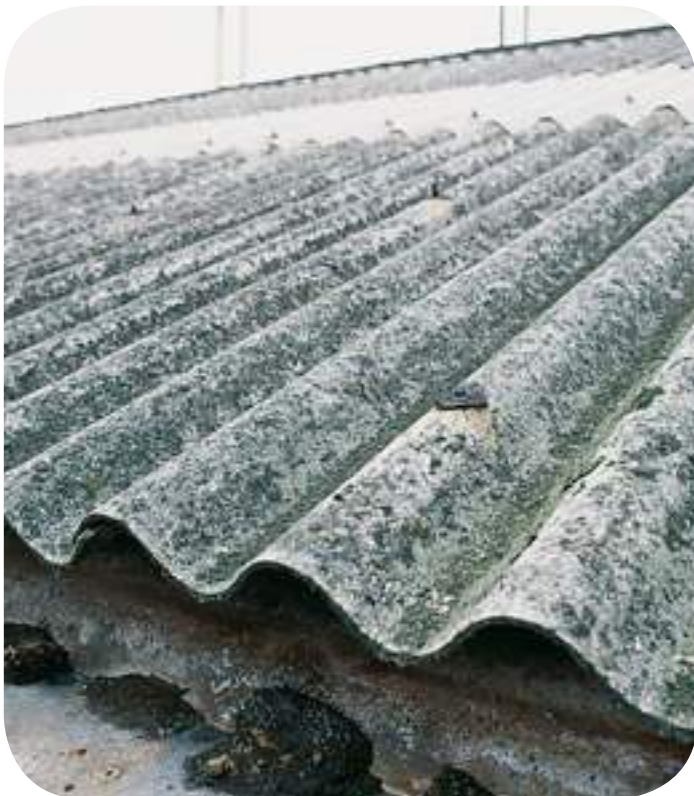
Toiture en amiante-ciment.
