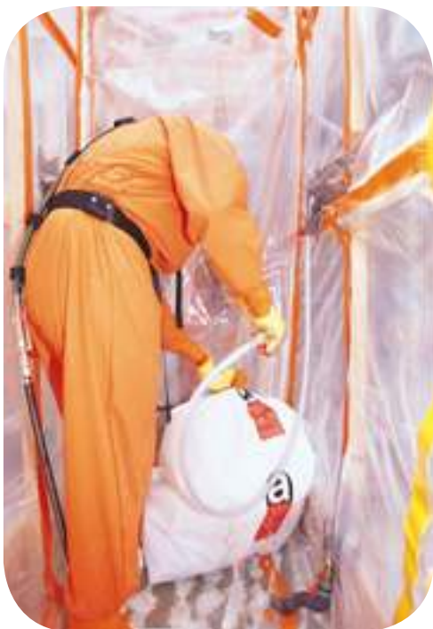
Le sac de déchets, étanche, fermé et marqué, est douché avant sa sortie de zone.
