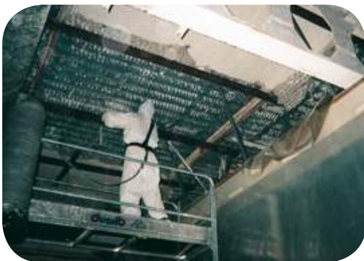
Retrait d'un enduit plâtreux projeté.
