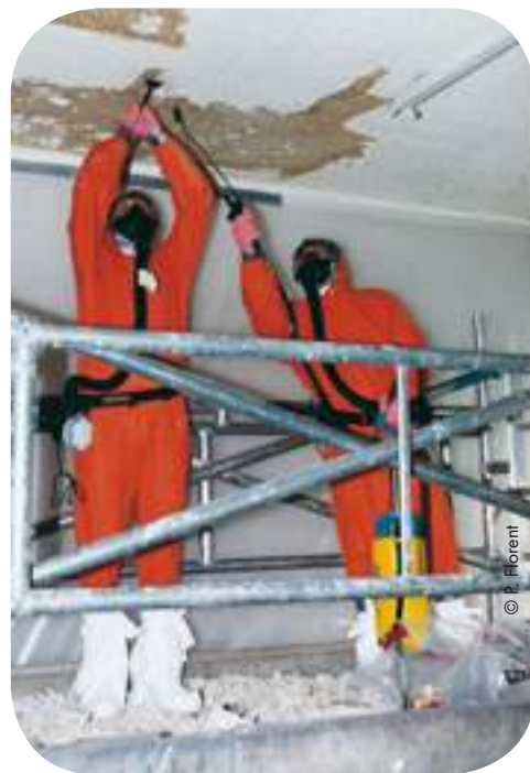
Grattage manuel d'un flochage sous aspersion d'un produit mouillant.
