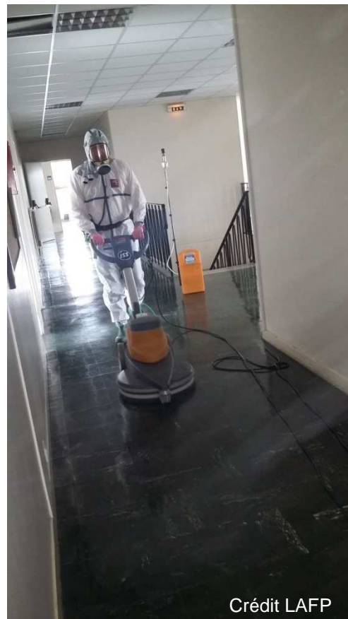
Site 1 - Bâtiment C
