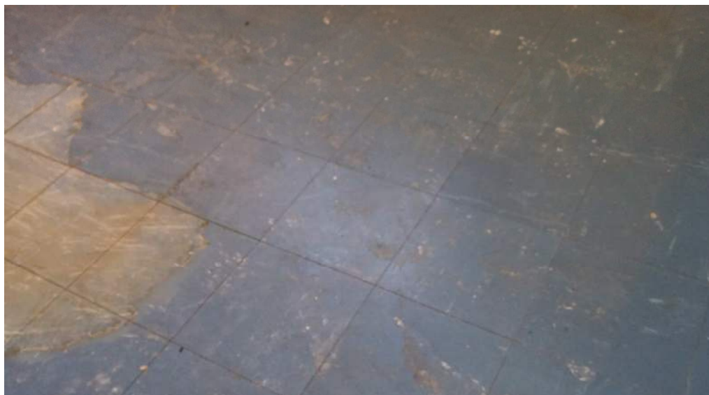
Figure 5 : Site 2 - Bâtiment B – Salle avec DVA bleues en bon état
